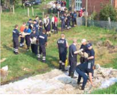
Deichverteidigung beim Elbe-Hochwasser
